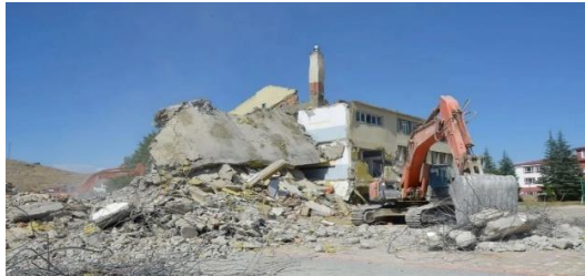
Resim 2. Depremden hasar alan bir okulda yapılan yıkım çalışmaları (Kahramanmaraş-2023)
